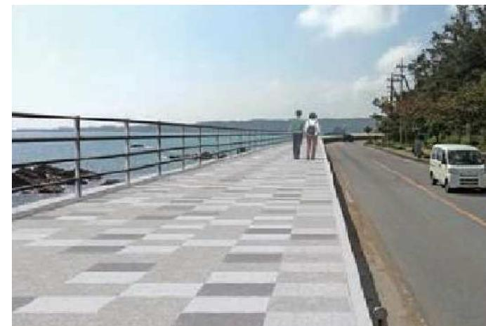
①低い護岸天端で越波を抑制
