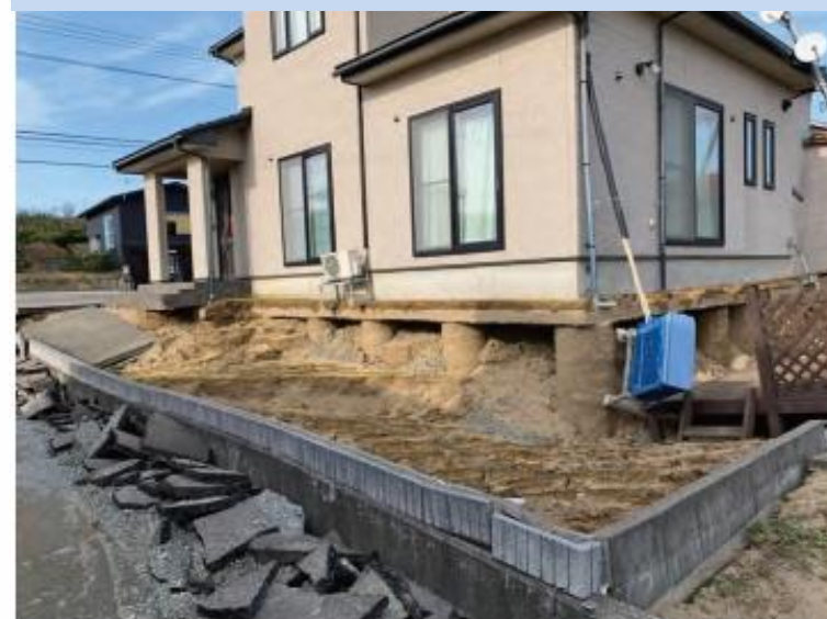
柱状改良されていたため 構造的な被害がなかった住宅 1)
