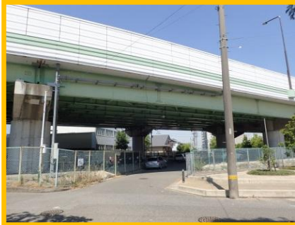
国道23号 北頭高架橋 (名古屋市南区)
