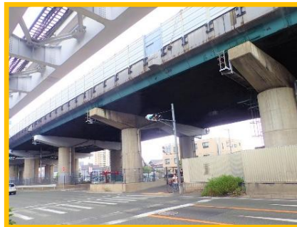
近畿自動車道松葉高架橋 (大阪府門真市)
