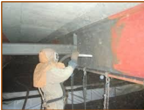
送気マスク着用によるブラスト施工
