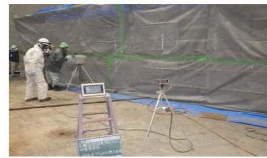
写真 1-● 湿粒ブラスト施工状況
