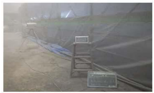
写真 1-● 乾式ブラスト施工状況
