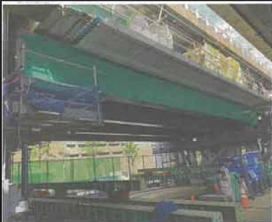
ジャッキアップ架設
