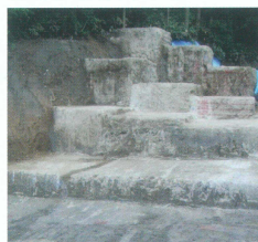
■改良体掘削後出来形
