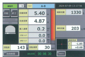
■ 施工管理装置「深度・流量・回転数・回転トルク」
