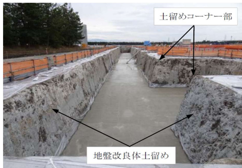
図2 土留め壁の完成
