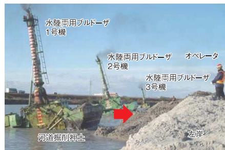
写真-10 掘削状況(庄内川)
