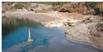
写真-18 掘削状況(矢作ダム)
