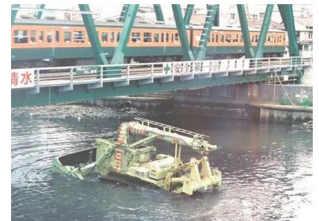
写真-9 橋梁下部の作業状況
