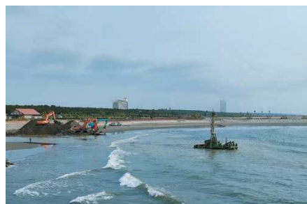
写真-20 掘削状況(宮崎サンビーチ)
