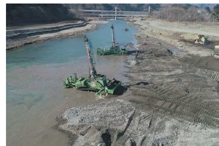
写真-13 掘削状況(小本川)
