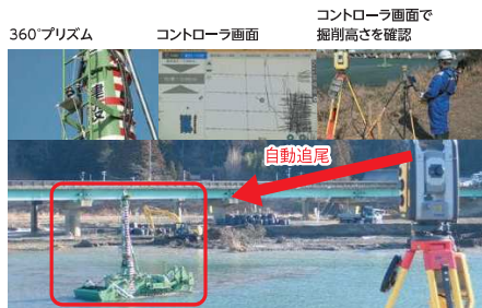
図-7 水陸両用ブルドーザに取り付けた360°プリズム(写真左上)を自動追尾するトータルステーション
