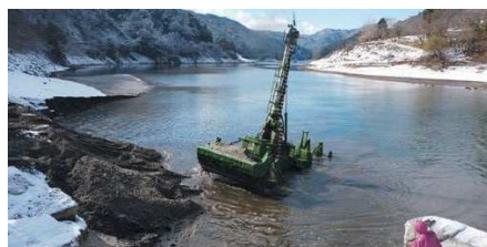
写真-17 掘削状況(矢作ダム)
