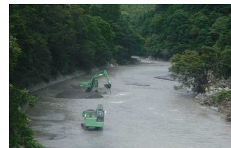
写真-16 掘削状況(下久保ダム)
