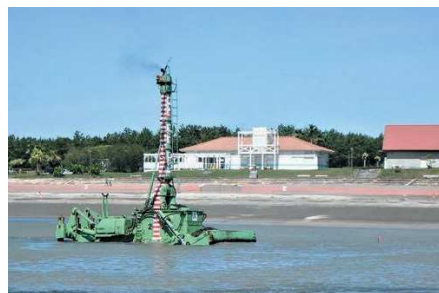
写真-19 掘削状況(宮崎サンビーチ)
