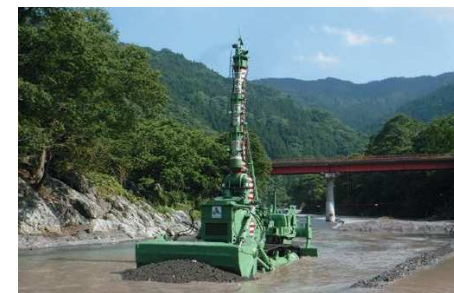
写真-15 掘削状況(下久保ダム)
