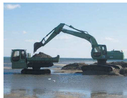
写真-21 掘削状況(雲出古川)
