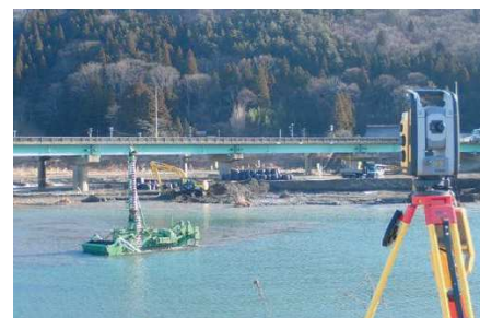
写真-14 ICT施工状況
