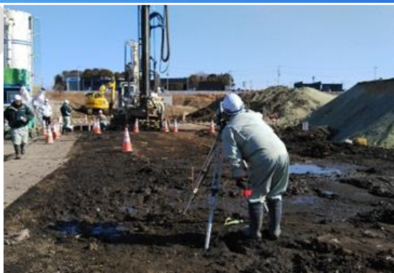
施工・計測状況
