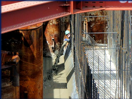
2021.5.18 岩手県大船渡市 大船渡港海岸茶屋前地区災害復旧(23災 166号)水門土木ほか工事 水中構造物の埋戻し
