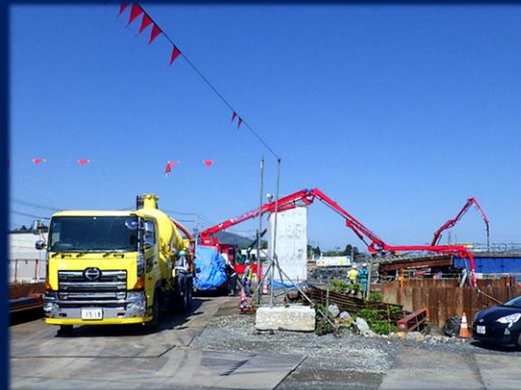
2018.5.11 宮城県気仙沼市 東北地方太平洋沖地震に伴う災害復旧 （気仙沼線第3大川護岸他） 水中構造物の埋戻し
