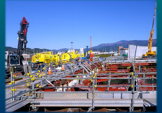
2020.10.31 岩手県大船渡市 大船渡港海岸茶屋前地区災害復旧(23災 166号)水門土木ほか工事 水中構造物の埋戻し
