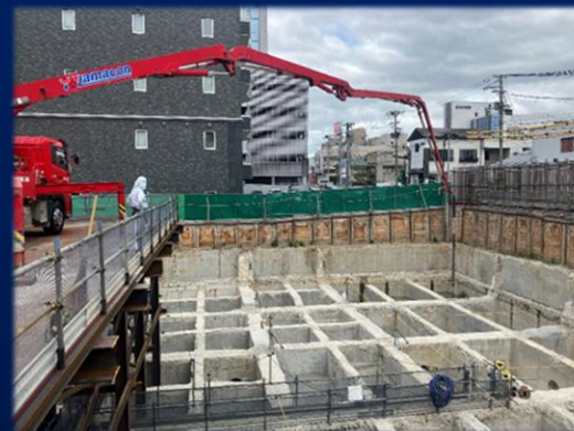
2024.5.30 山形県山形市 七日町第8ブロック南地区暮らし・にぎわい再生事業 地下構造物の埋戻し
