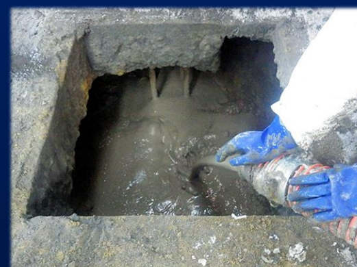
2022.1.21 岩手県一関市 前田道路一関合材工場 地下空間の充填
