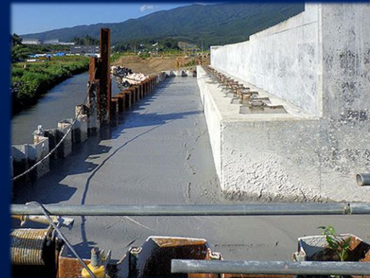
2018.9.5 岩手県陸前高田市 平成28年度 高田地区高台部整備その他工事 埋戻工 小泉川橋梁 基礎周辺の埋戻し
