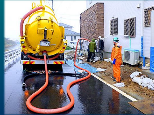
2017.10.7 宮城県気仙沼市 地盤補強工事 小規模空洞の充填
