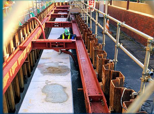
2016.12.21 岩手県下閉伊郡山田町 山田漁港海岸災害復旧（上下水道管移設）工事 埋設管の受け防護
