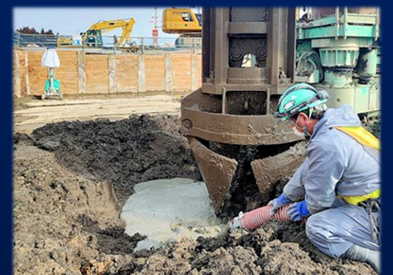
2022.3.1 岩手県北上市 北上材工業(株)栗田工業(株)水処理設備作業所 地下空間の充填
