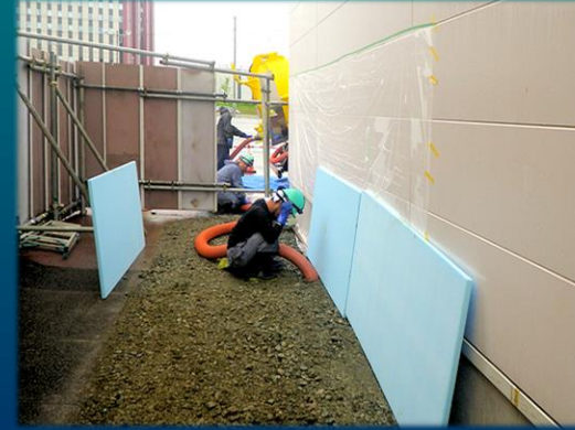
2020.7.8 岩手県紫波郡矢巾町 BH矢巾タウン セリア棟建物不動沈下是正工事 小規模空洞の充填
