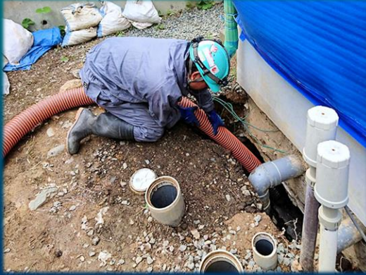
2020.5.24 岩手県盛岡市 民間工事 小規模空洞の充填
