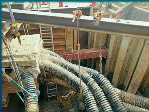
2022.4.7 岩手県北上市 第一北上中部工業用水道浄水場建設事業 地下空間の充填
