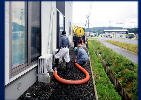
2019.6.25 岩手県盛岡市 沈下修正工事 小規模空洞の充填
