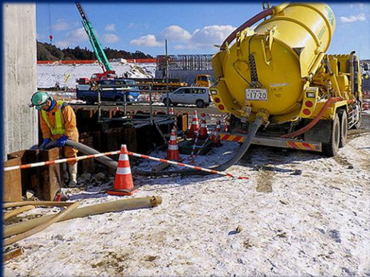
2018.1.29 宮城県気仙沼市 H29年度 宮城気仙沼(南気仙沼6)総合工事 地下空間の充填
