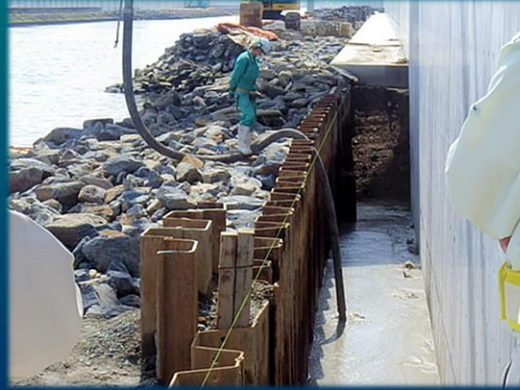
2020.5.25 宮城県気仙沼市 東北地方太平洋沖地震に伴う災害復旧 (気仙沼線第3大川B新設) 水中構造物の埋戻し
