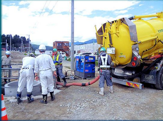
2016.7.19 岩手県下閉伊郡山田町 平成27年度 織笠地区・山田地区上下水道工事 埋設管の受け防護
