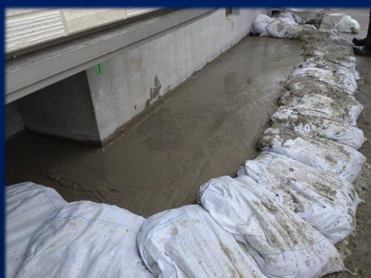
2022.1.20 宮城県登米市 (株)富貴様ハイグレード住宅沈下修正工事 小規模空洞の充填
