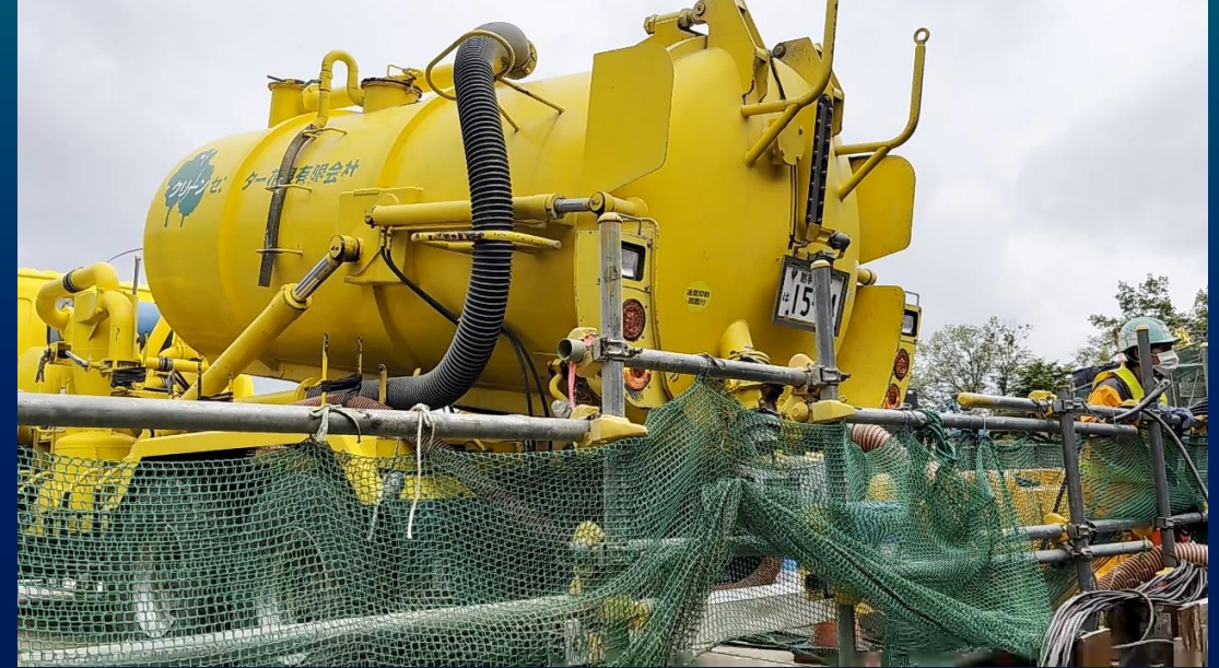
2020.6 東北自動車道 吉原橋（叩き橋脚） 耐震補強工事
