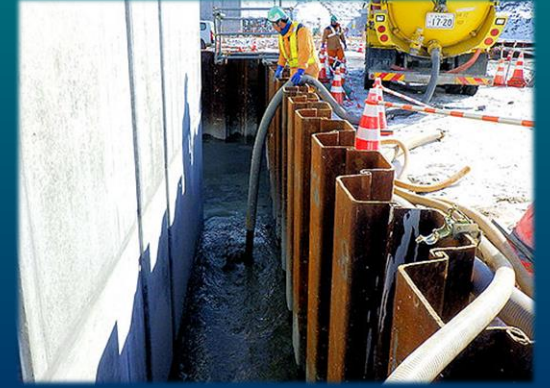
2018.1.15 岩手県下閉伊郡山田町 平成28年度 高田地区高台部宅地整備その他工事 地下構造物の埋戻し
