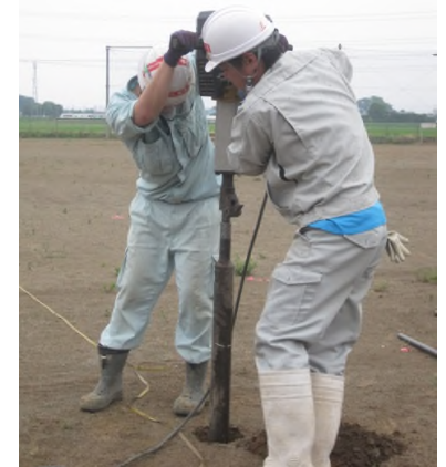
簡易ボーリング調査 実施状況
