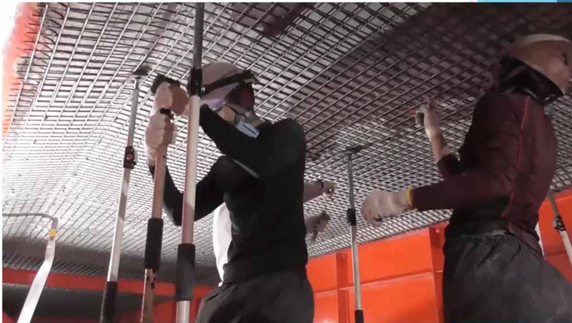
格子状溶接鉄筋 固定状況
