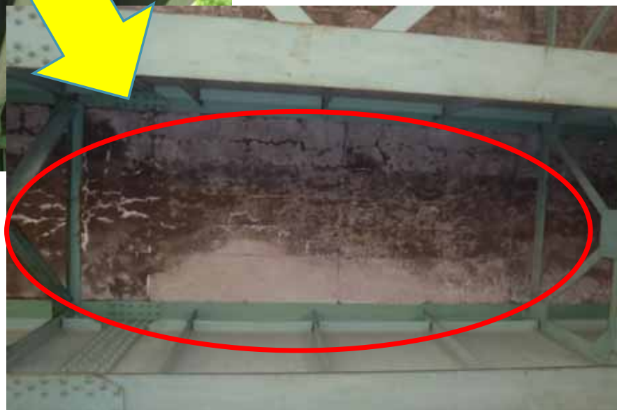
図4.7.3-1 鉄筋コンクリート床版の下面のひび割れと劣化状態
