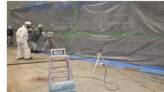
写真1-● 湿粒ブラスト施工状況
