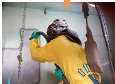
ブラスト作業中の送気状況 (防護フード及びブーツ内に 浄化空気が常に送気される)
