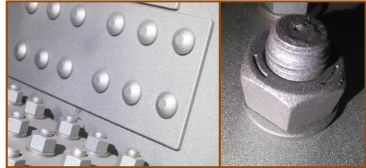
添接部でもきれいに除錆・塗膜除去が可能
