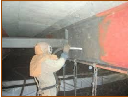
送気マスク着用によるブラスト施工
