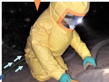
回収作業中の送気状況 (回収作業もブラスト同様 浄化空気が常に送気される)
