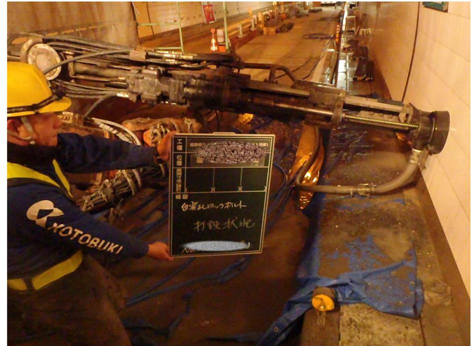
供用中トンネル補強ロックボルト打設
