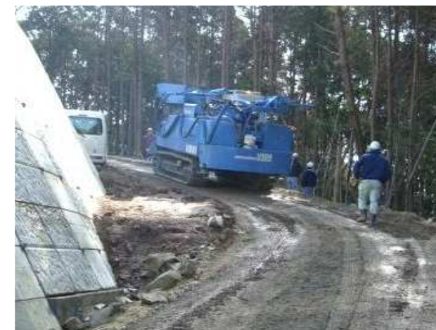
【施工機搬入状況】 現場入口より自走 最大登坂能力15度
