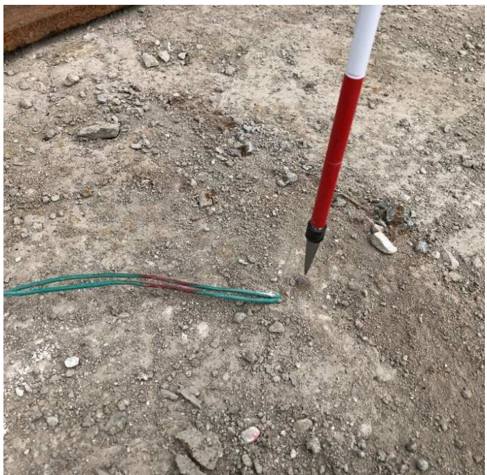
杭芯セット完了
