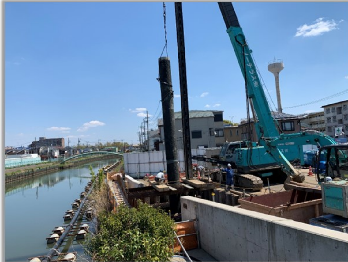
東京都:新花畑橋(仮称)護岸工事及び人道橋撤去工事
