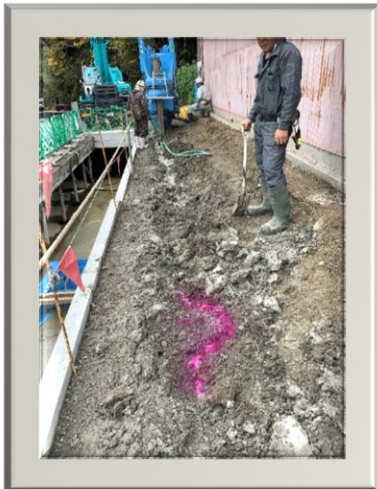
アルカリ性の充填材がフェノール フタレイン溶液に反応
