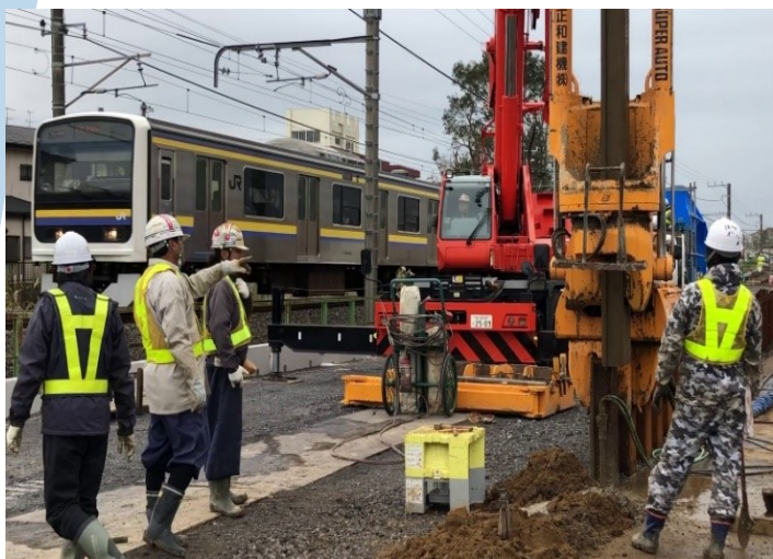
鉄道近接工事の実績あり
