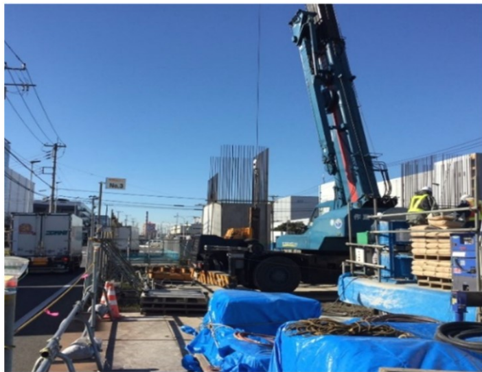
川崎市 東扇島臨港道路 アプローチ橋梁下部工事
