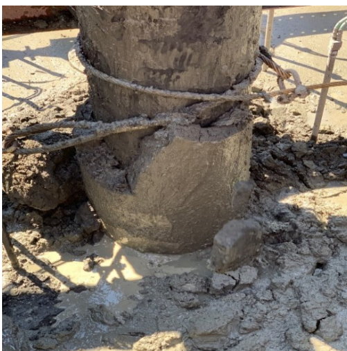
杭の引抜きにも使えます
