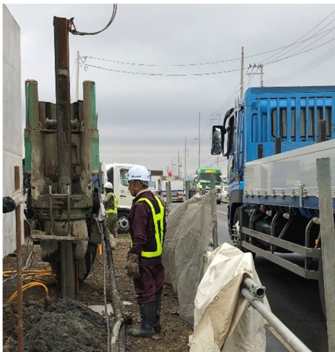
名取市 閑上小塚原線 小塚原跨道橋新設工事
