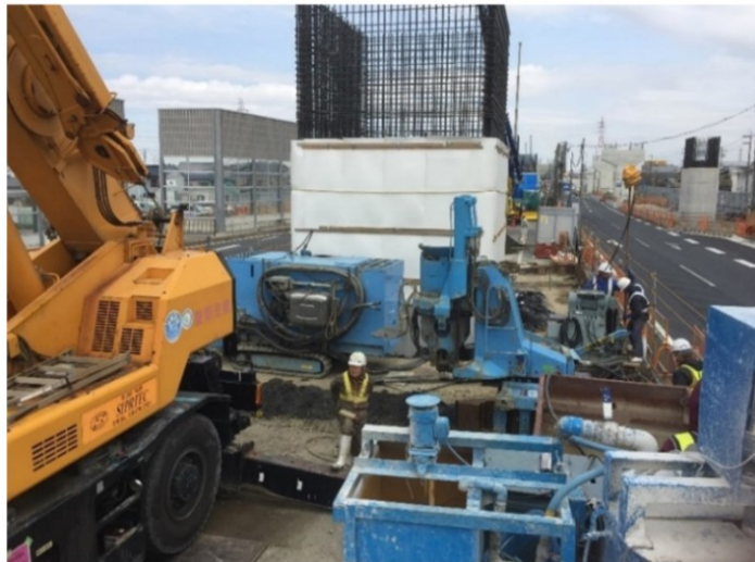
国交省愛知国道事務所 環西蟹田南高架橋下部工事
