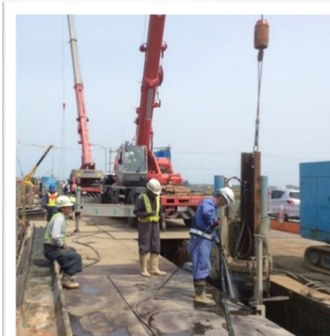
日本下水道事業団 岩沼市二野倉排水路復興建設工事
