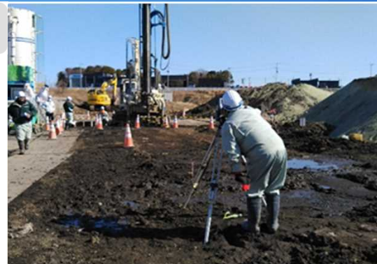
施工・計測状況
