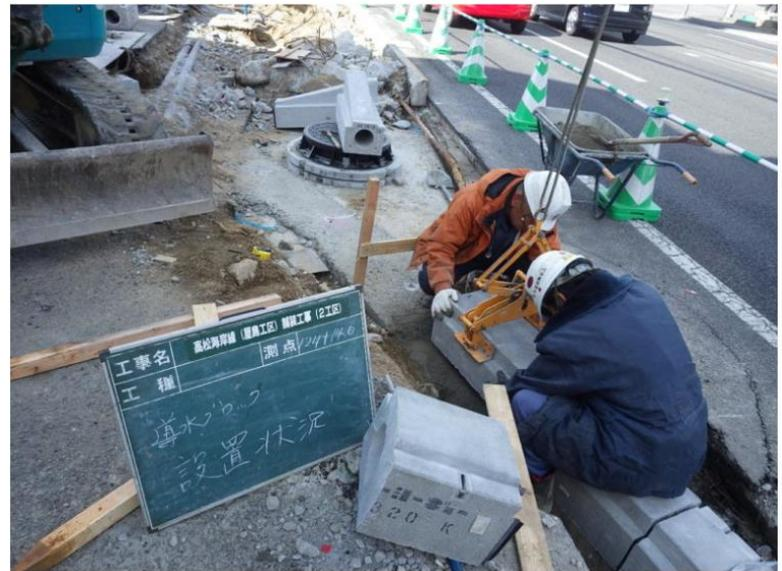
専用の吊り具を用いて、導水ブロックを設置していきます。
