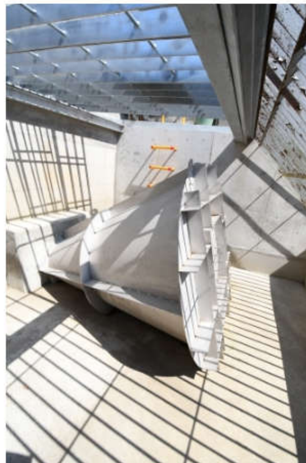
出典:平塚市役所ホームページ 記者発表資料「全国初の特殊バルブによる調整池からの雨水流出抑制」より
