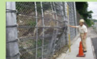
落石・崩壊土砂対策 ループフェンス
