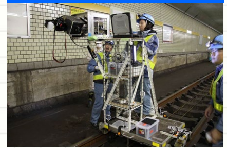
地下鉄開削トンネル
