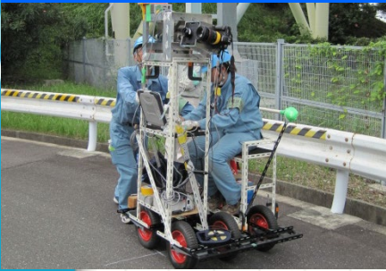
LNGタンク防液堤
