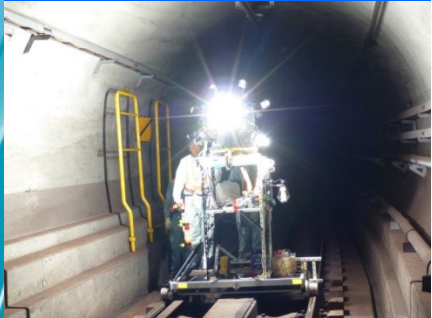
地下鉄シールドトンネル
