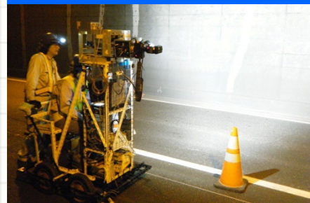
道路開削トンネル
