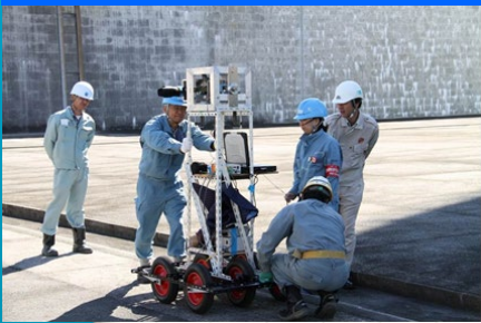
LNGタンク防液堤
