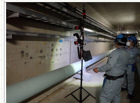
配管裏撮影状況
