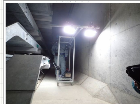
撮影カートによる床版撮影状況
