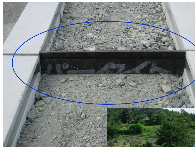
防草タイト敷設
