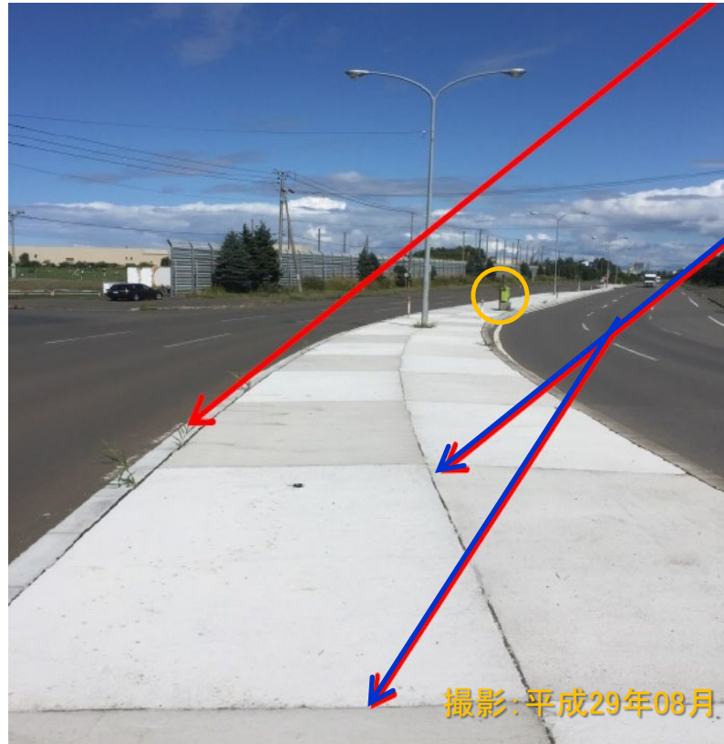
施工後03ヶ月経過
