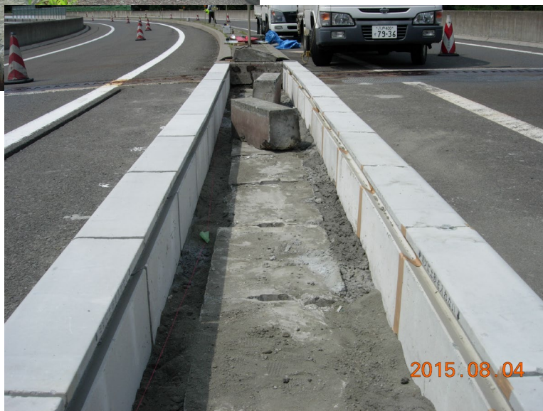
防草ブロック敷設
