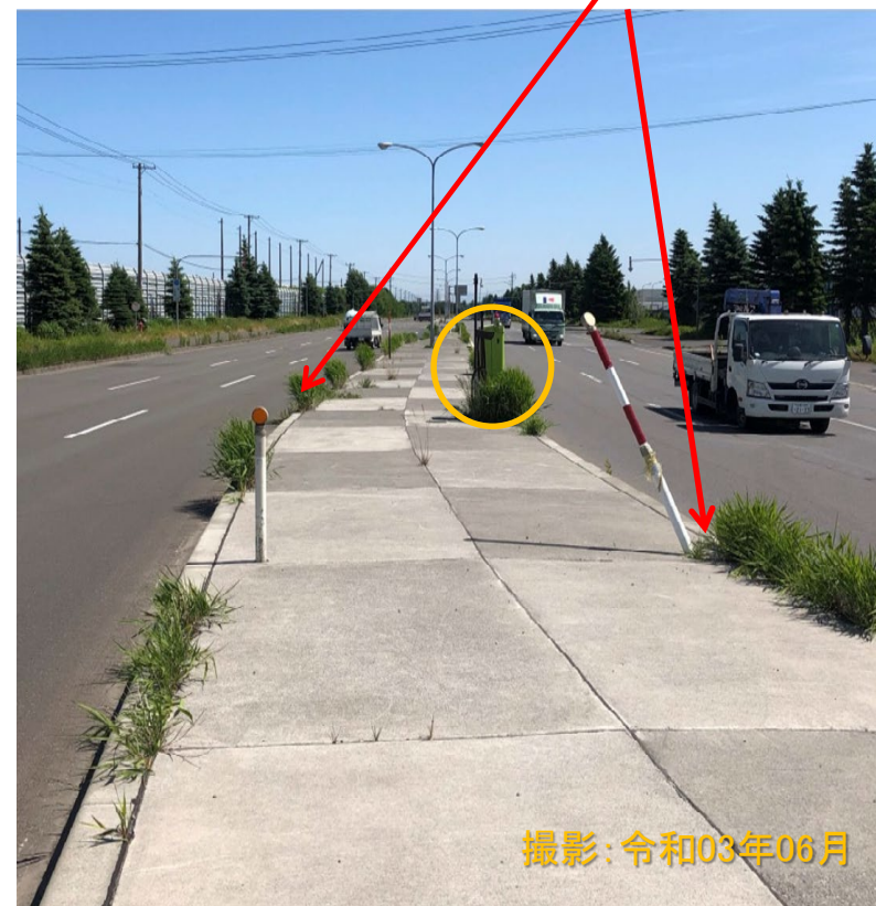
施工後49ヶ月経過
