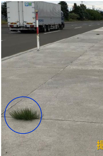
施工後12ヶ月経過
