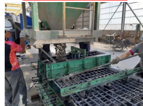
コンクリート打設
