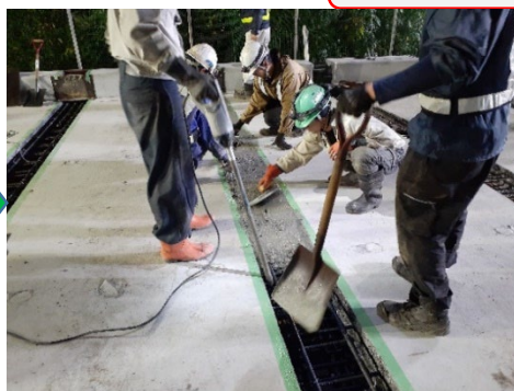
間詰部コンクリート打設
