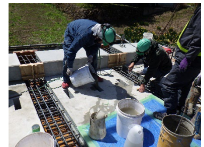
無収縮モルタルの充填
