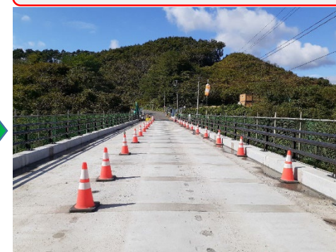
TKM床版設置完了
