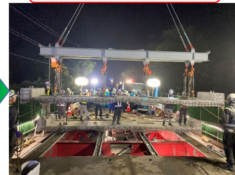
TKM床版架設
