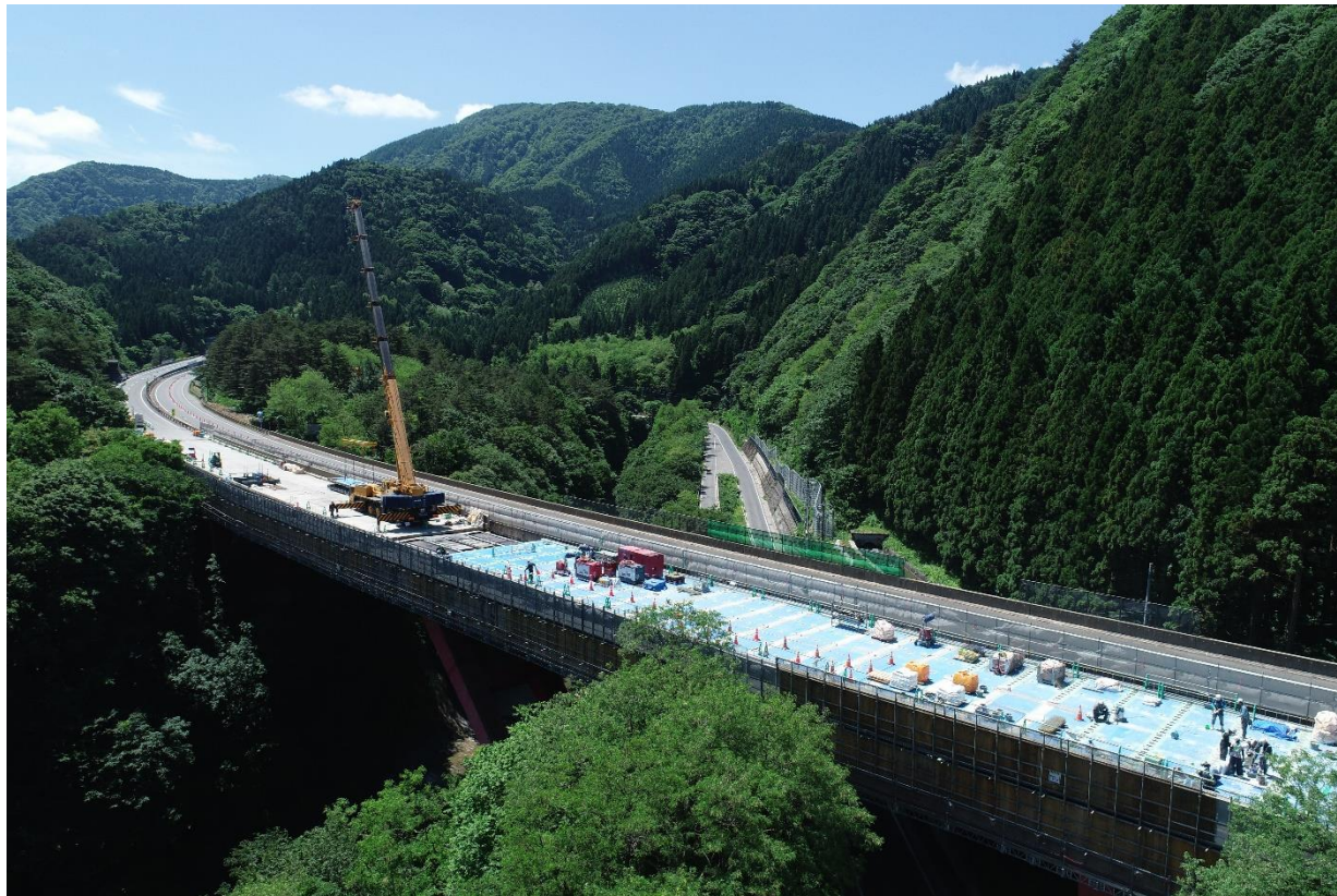
鋼V脚式連続ラーメン橋（L=181.5m） 床版取替面積：2,028m 2
