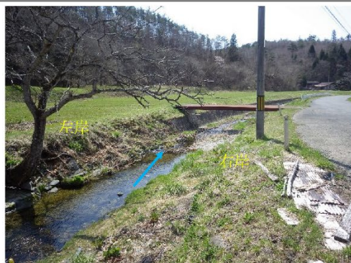
【現地写真（No. 2（0.2k）付近）】（撮影：2021年4月8日）
