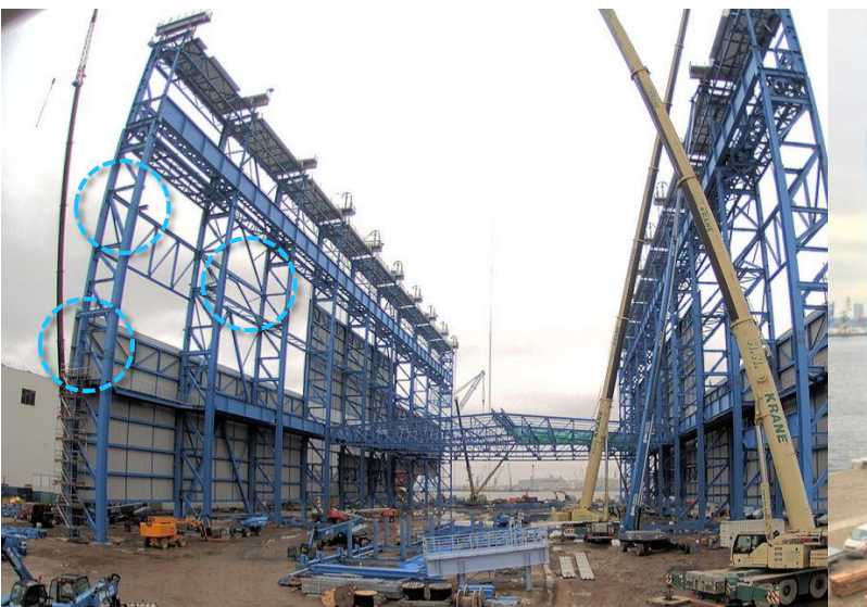
造船所の鉄骨構造物締結部（ドイツ）
