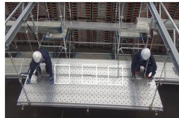
仮設機材(足場)
