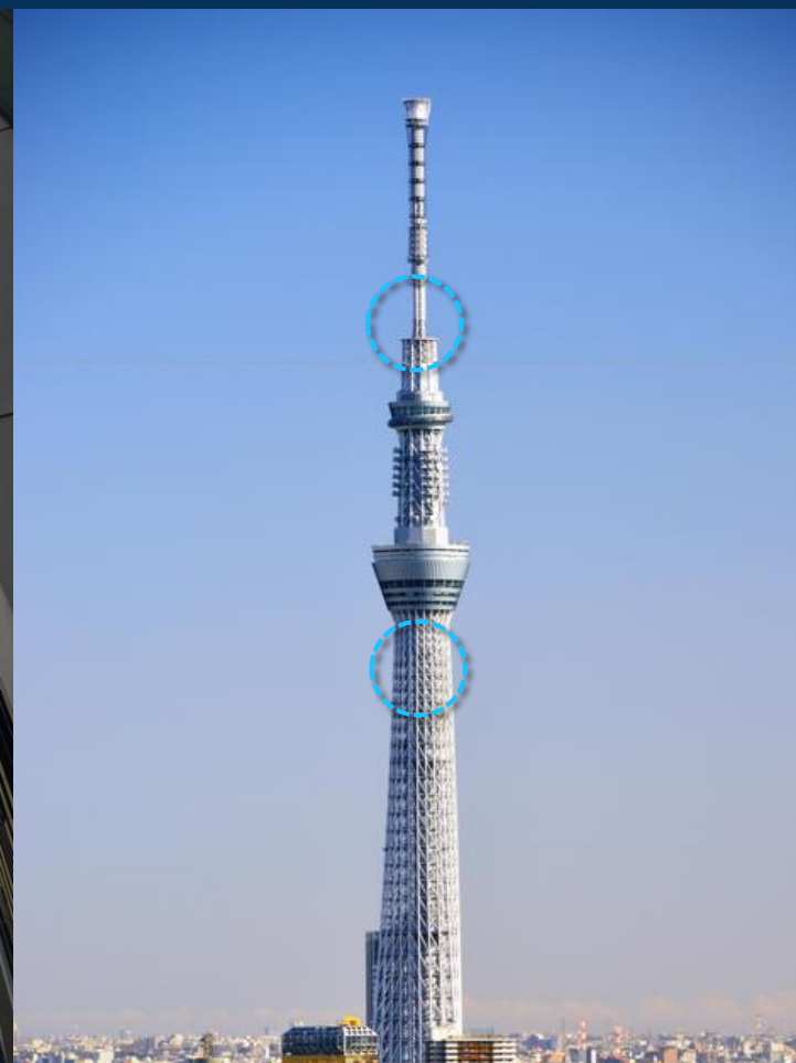
スカイツリー：アンテナの固定部など（日本）
