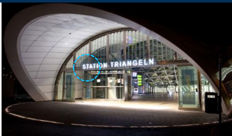
駅舎：鉄骨+ガラス構造物（スウェーデン）
