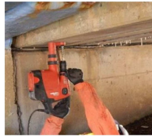
塩化物イオン測定のための、削孔による試料採取
