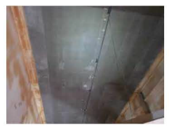
光ファイバーセンサによる橋梁モニタリング
