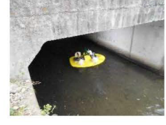
水上ドローンによる損傷把握
