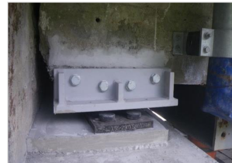
既設コンクリートT桁の支承取付部材への充填材として使用した例
