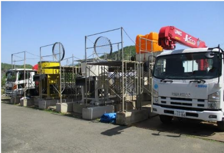
現場での練り混ぜ状況
