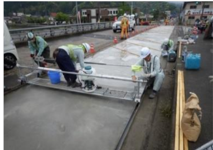
連続打設とシート養生
