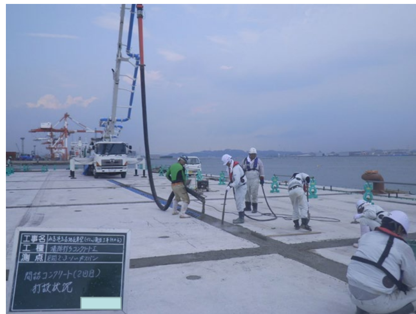
間詰コンクリート打設状況
