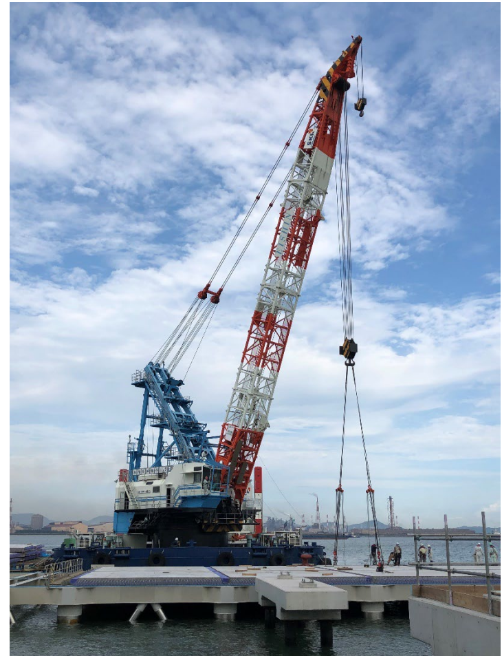
RC床版据付け状況
