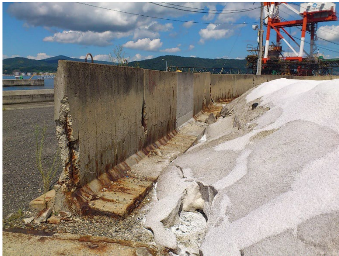
普通コンクリート
