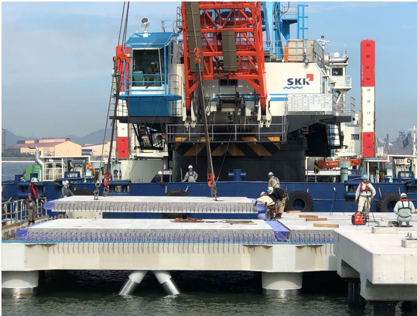
RC床版据付け状況
