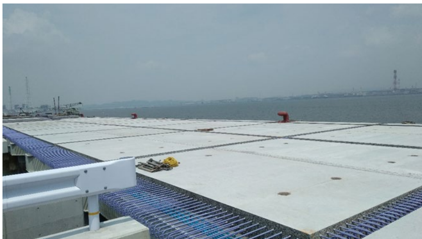
RC床版据付け完了
