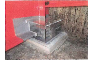
図-4.1.14 支承部を樹脂で充填した事例 9)
