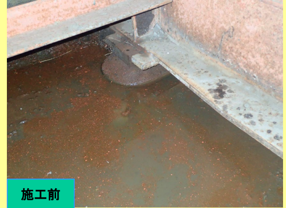
滞 水 す る 橋 座 で の 支 承
