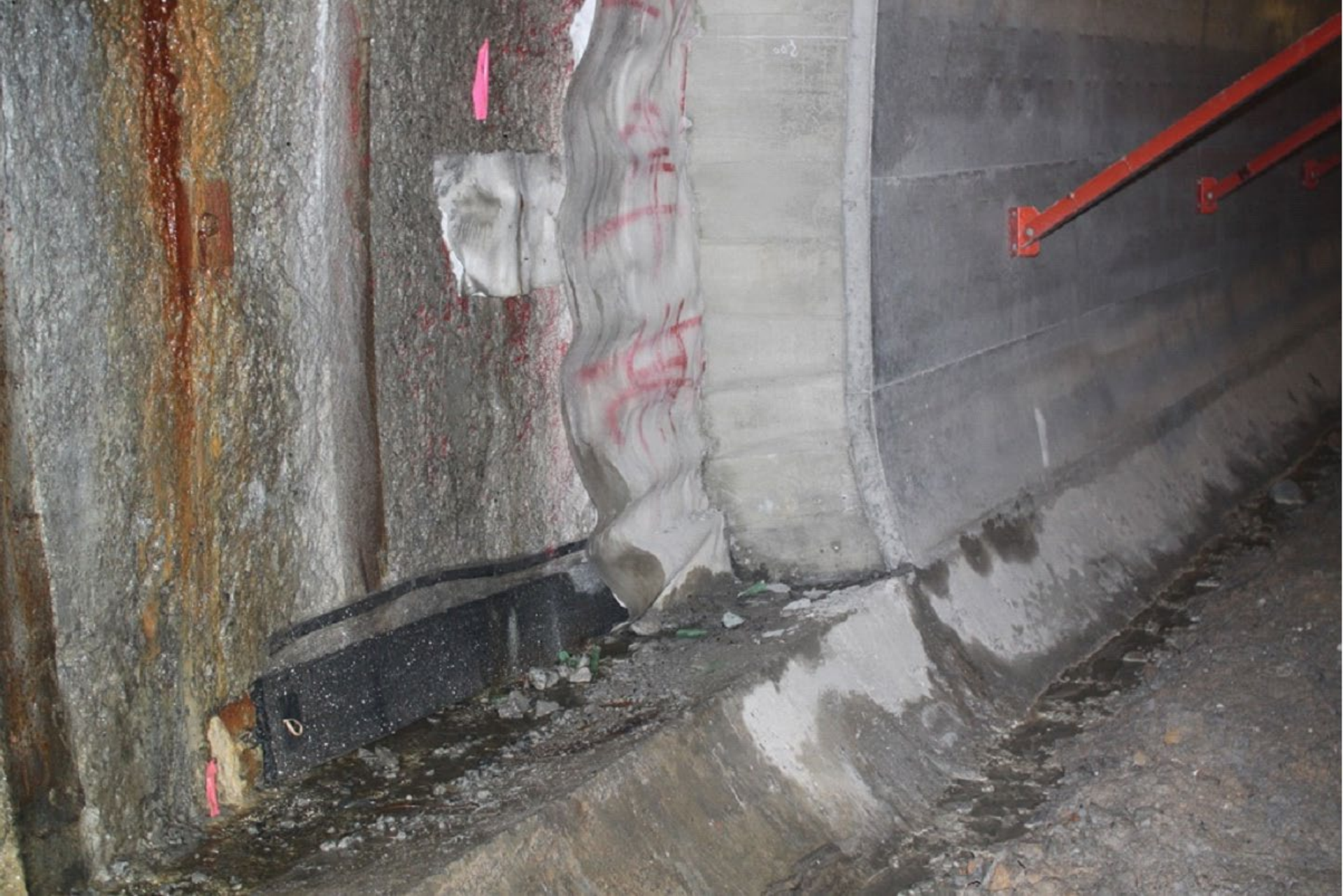
覆工コンクリート打設後の防水シート
