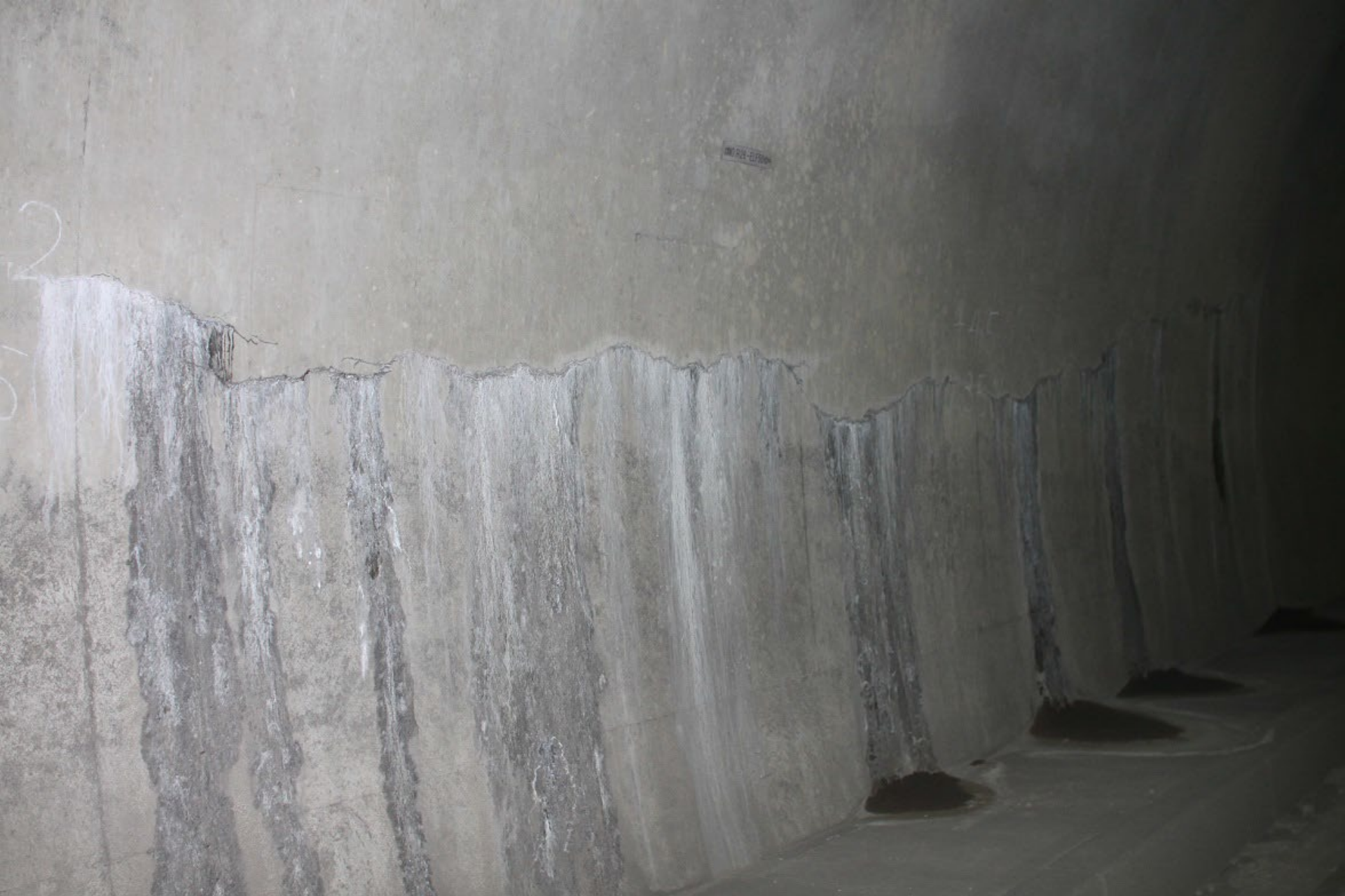
完成後約 5 年のトンネル
