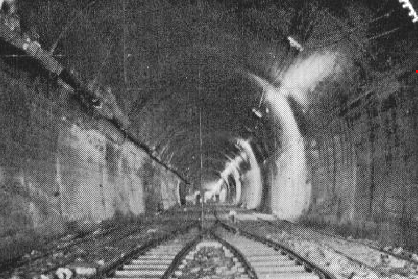
上部半断面先進逆巻工法によるトンネル建設
