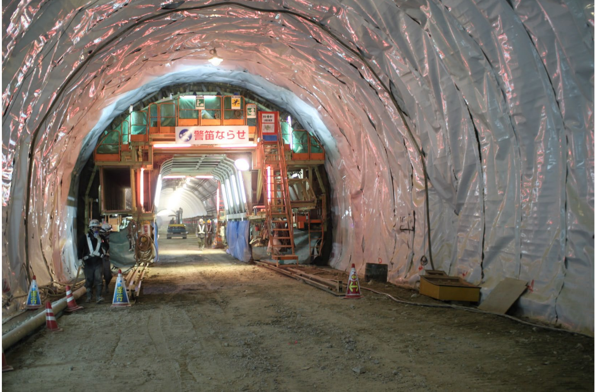
防水シート設置状況
