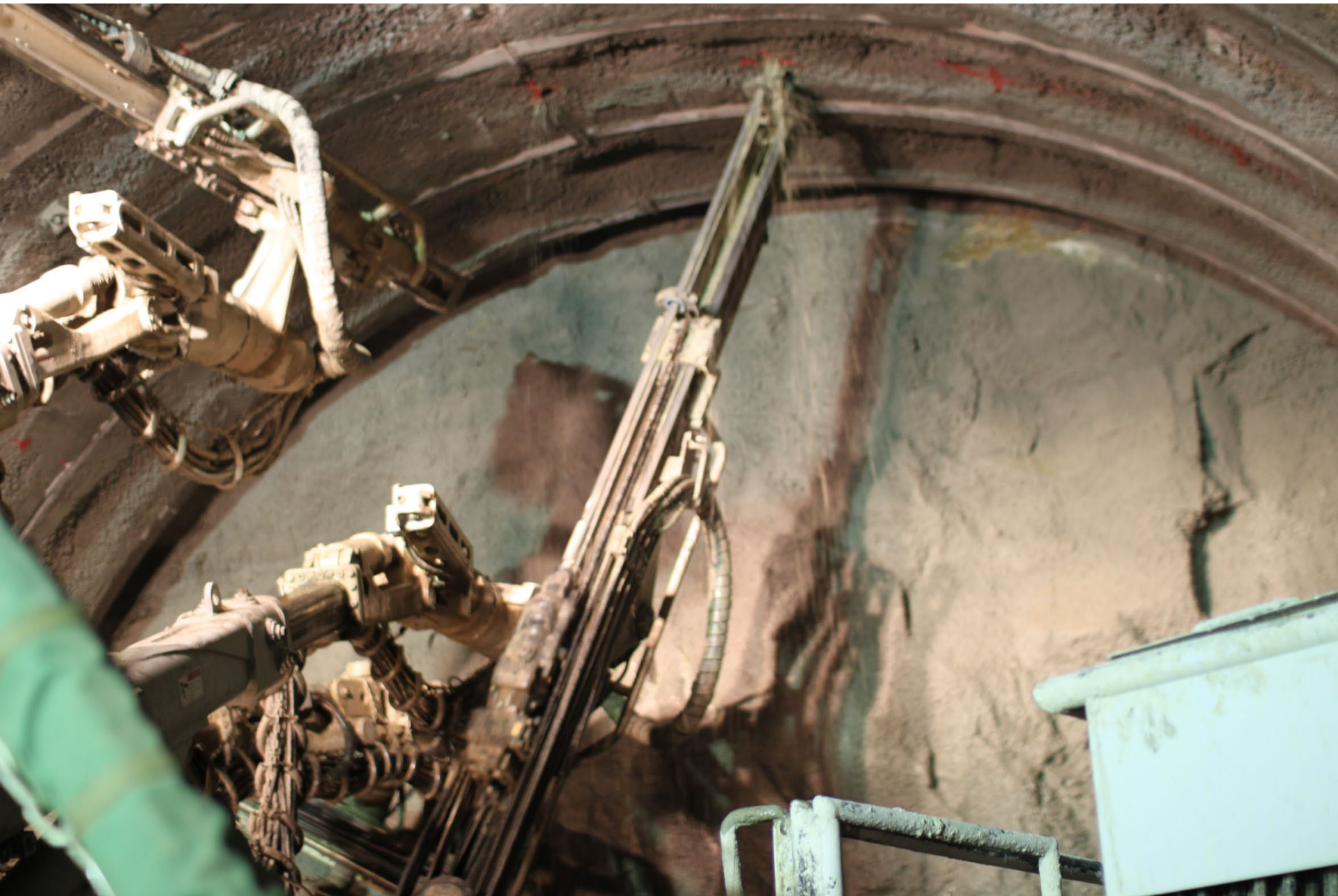
NATM工法によるトンネル建設
