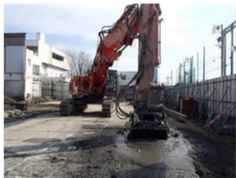
土留め壁造成
