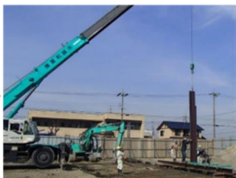
芯材(H鋼)立込み
