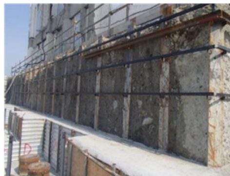
土留め壁拡大
