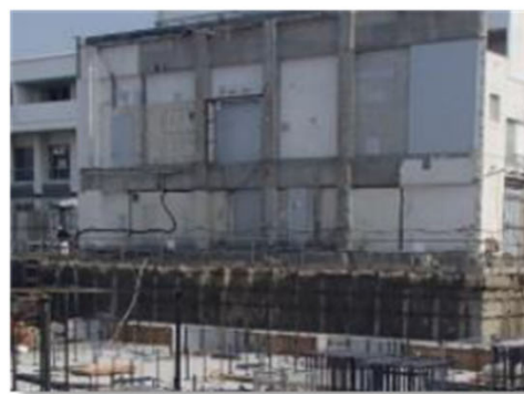
土留め壁造成後、掘削完了
