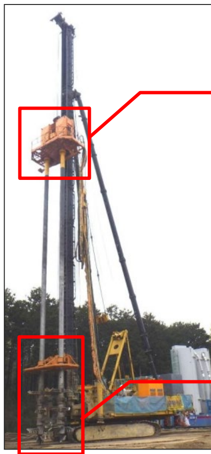
施工状況全景
