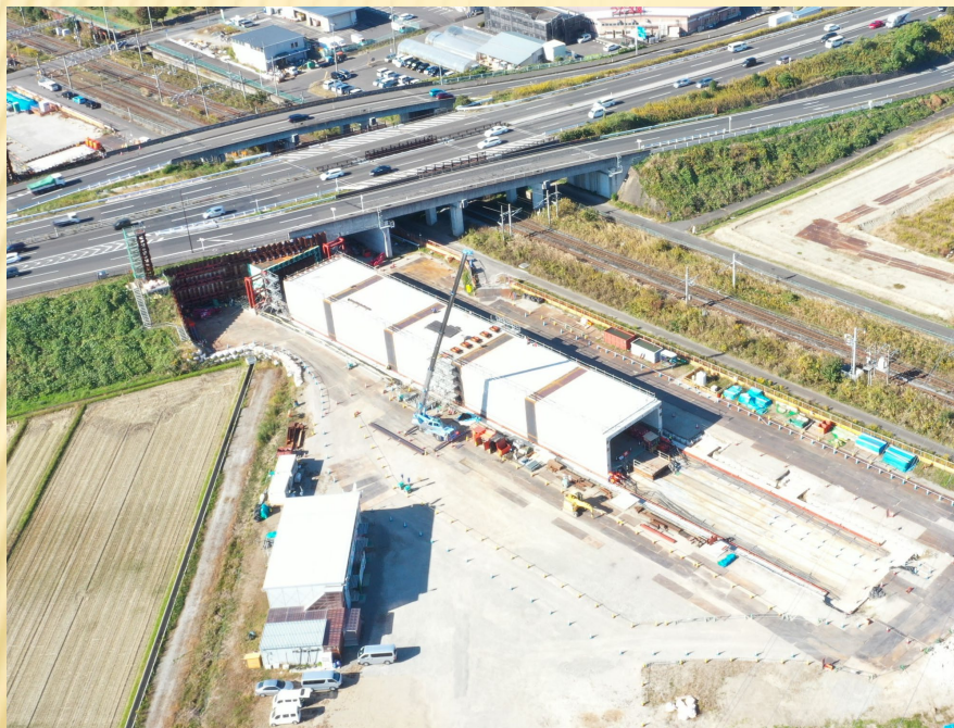
函体空推進状況(上空)
