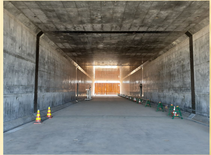
推進完了②(函体内)
