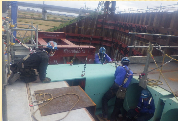
ジャッキ収納管設置状況
