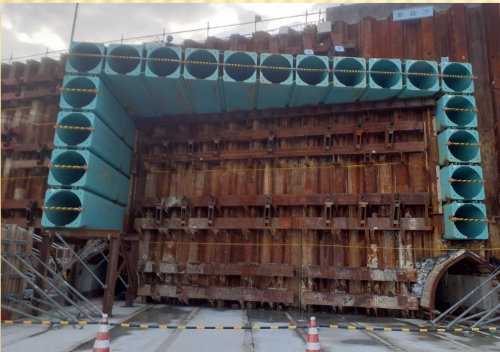
箱型ルーフ推進完了(正面)
