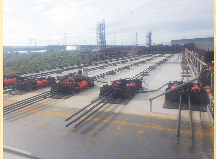
函体上部FC制御設備②
