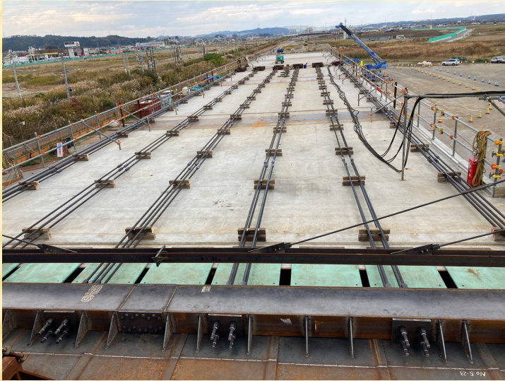
函体上部FC制御設備①
