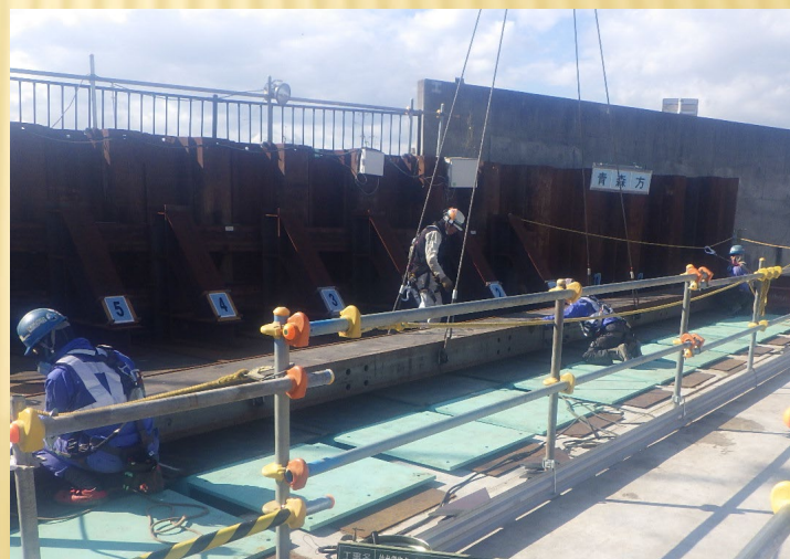
FC制御用不動梁設置状況
