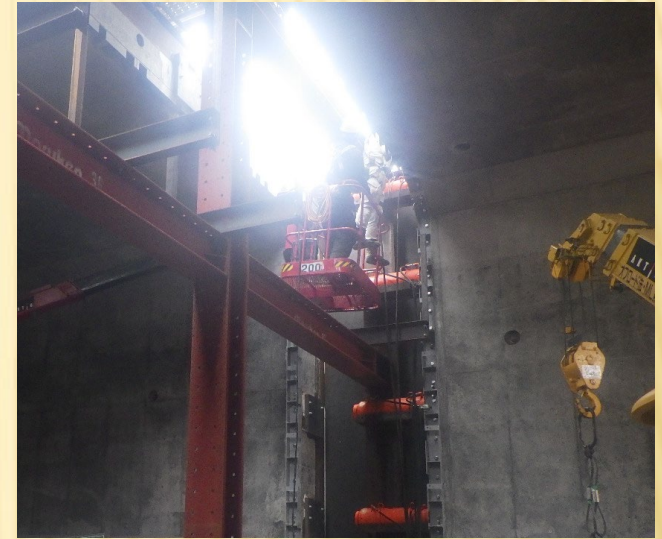
中押しジャッキ設置状況
