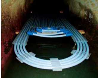
採熱管設置状況
