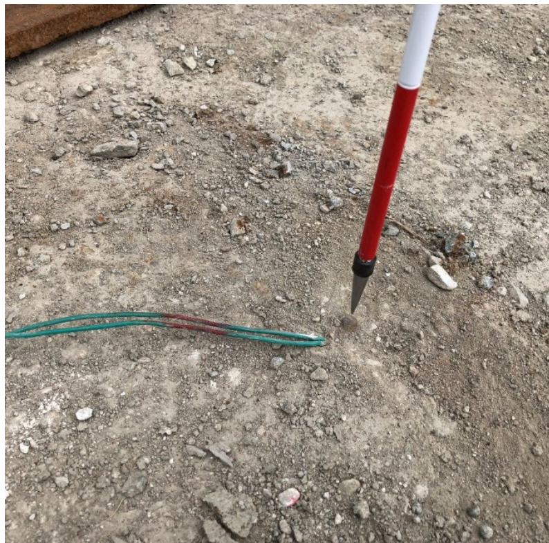
杭芯セット完了
