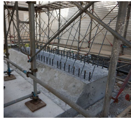
同一断面,塑性ヒンジでの継手
