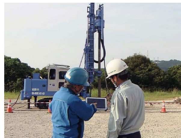
機械から離れて施工管理
