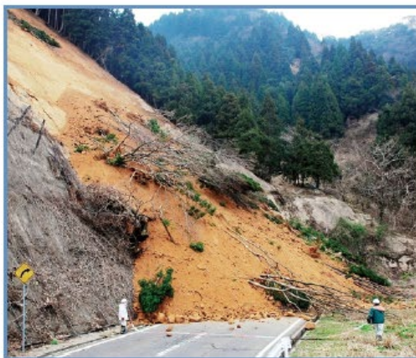
災害発生土砂
