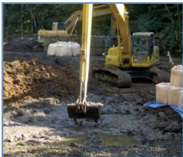
ため池堆積土
