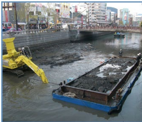
河川・港湾浚渫土
