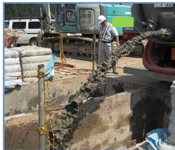
各種建設汚泥
