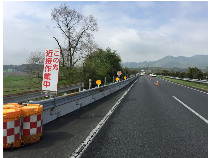
工事区間の安全確保
