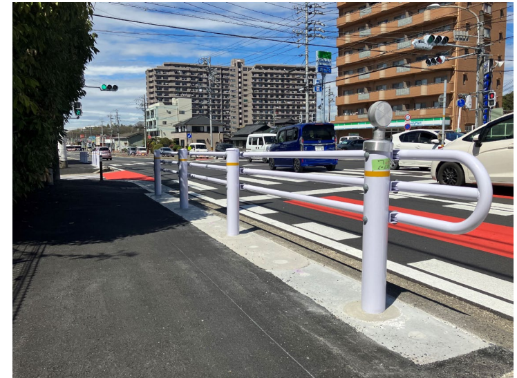
埋設基礎で設置
