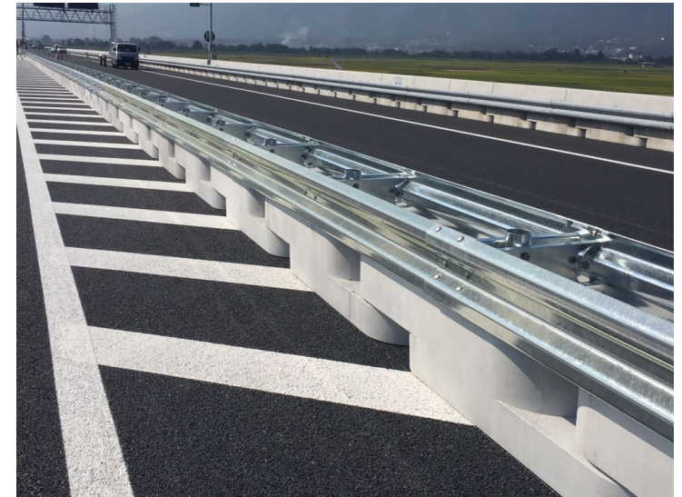
暫定供用区間の車線規制
