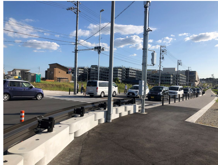
置き式基礎で設置
