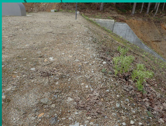
堤体頂部の様子
