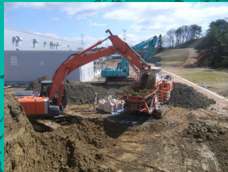
自走式改良機に投入
