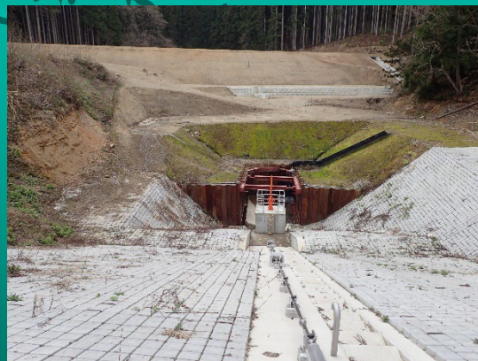
ため池底部の様子
