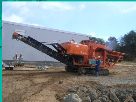
建設発生土(低含水比)
