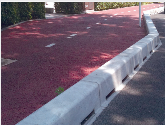
宮城県仙台市役所 宮城野通線自転車道整備工事 (H22)
