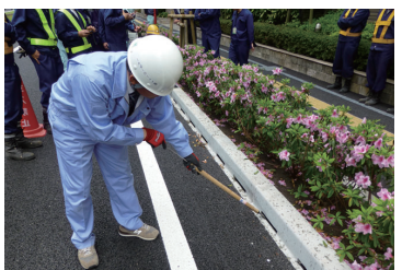
スリットの清掃は、工具を使用して行います。(※高圧洗浄による清掃も可能)
