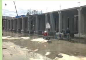
地下式雨水貯留槽
