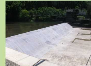
摩耗、洗堀対策用 高強度繊維補強コンクリートパネル
