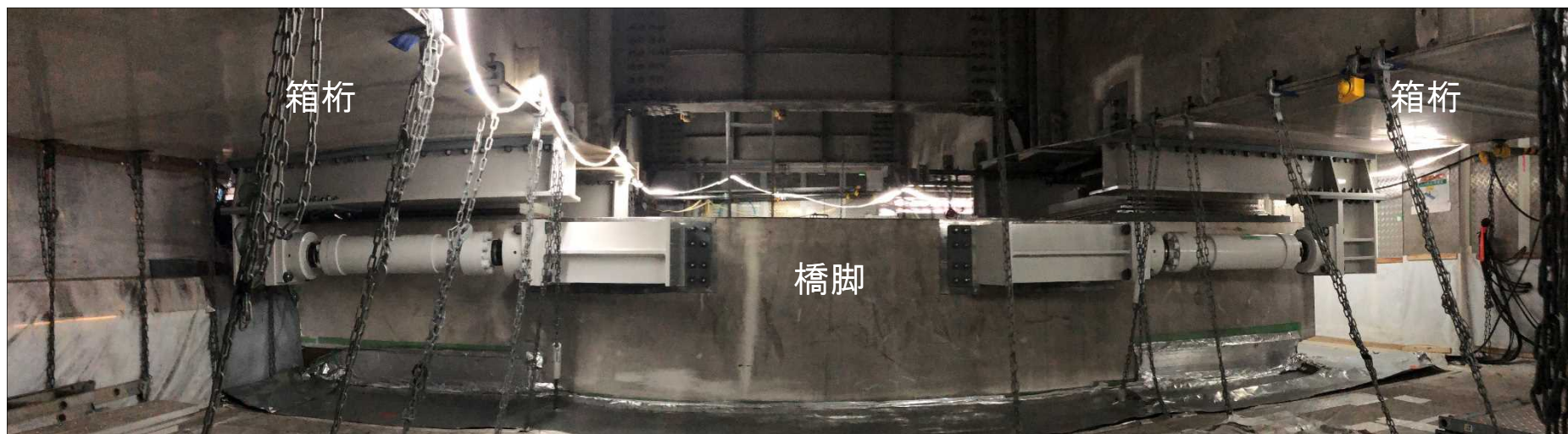
(a) 設置完了の全景
