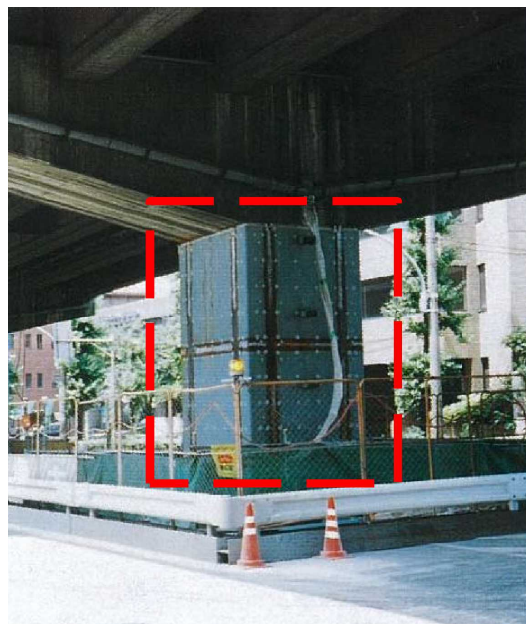
コンクリート橋脚へ鋼板巻き立て
