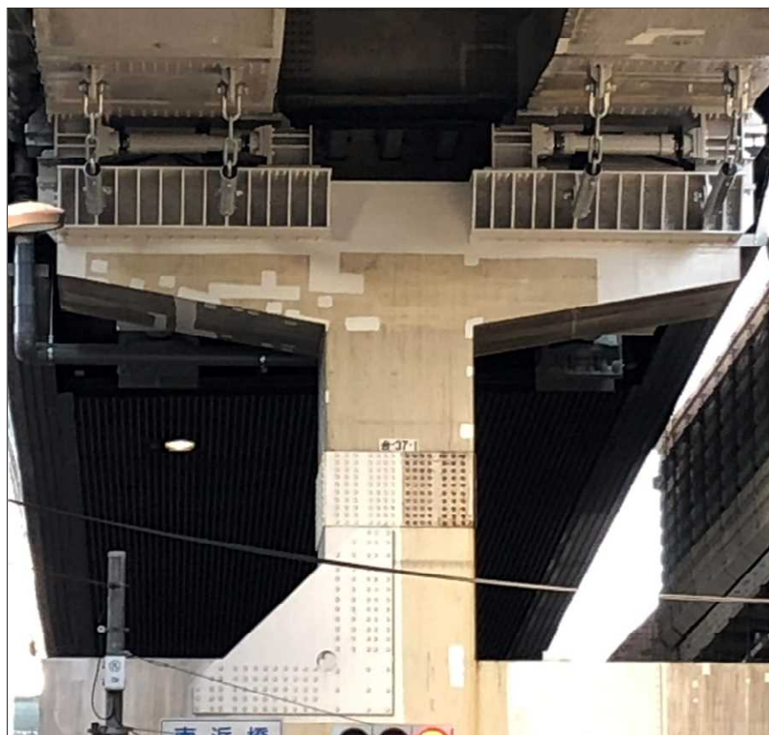
(d) 設置完了の全景
