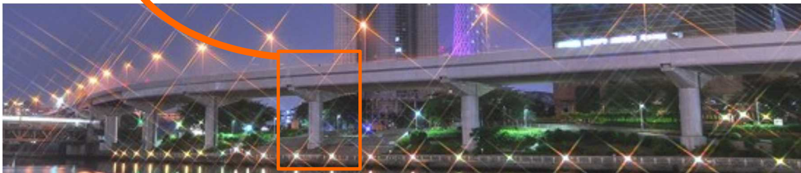
首都高速6号向島線 (RC造単柱橋脚)
