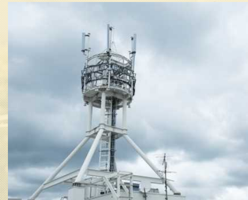
▲無線基地局工事
