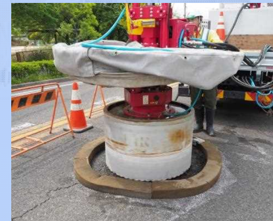
▼土木設備工事
