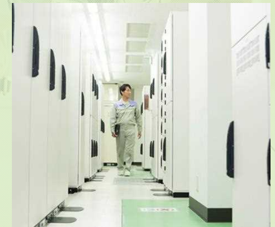
▼ユーザー設備工事
