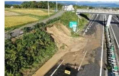
高速道路法面の崩壊確率を予測
