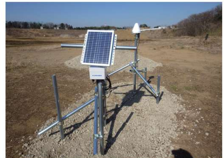
計測機器設置状況
