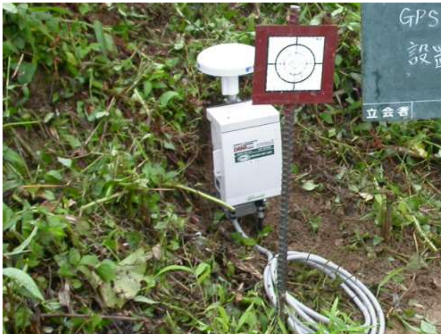
GNSSセンサー設置状況 (MG-3111)
