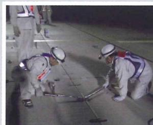
6 コッター式継手締付状況
