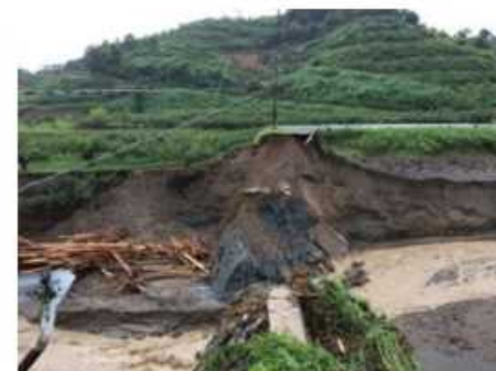
平成29年7月の豪雨により決壊（福岡県）
