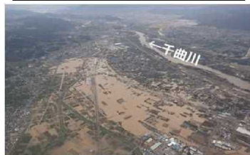
千曲川における浸水被害状況 (長野県長野市)
