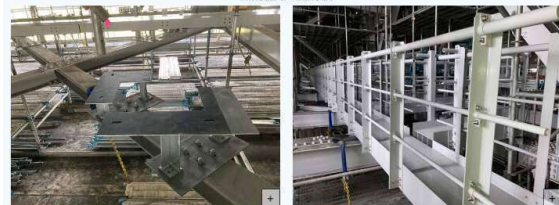
架台金具の設置状況/下段検査路設置状況
