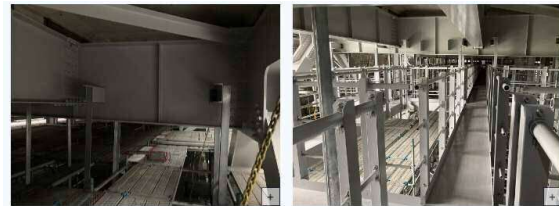
上段検査路の設置状況
